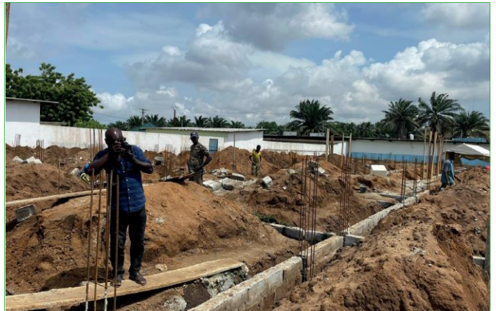
• L'équipe REMEDES en visite de chantier à ANONO-RIVIERA
